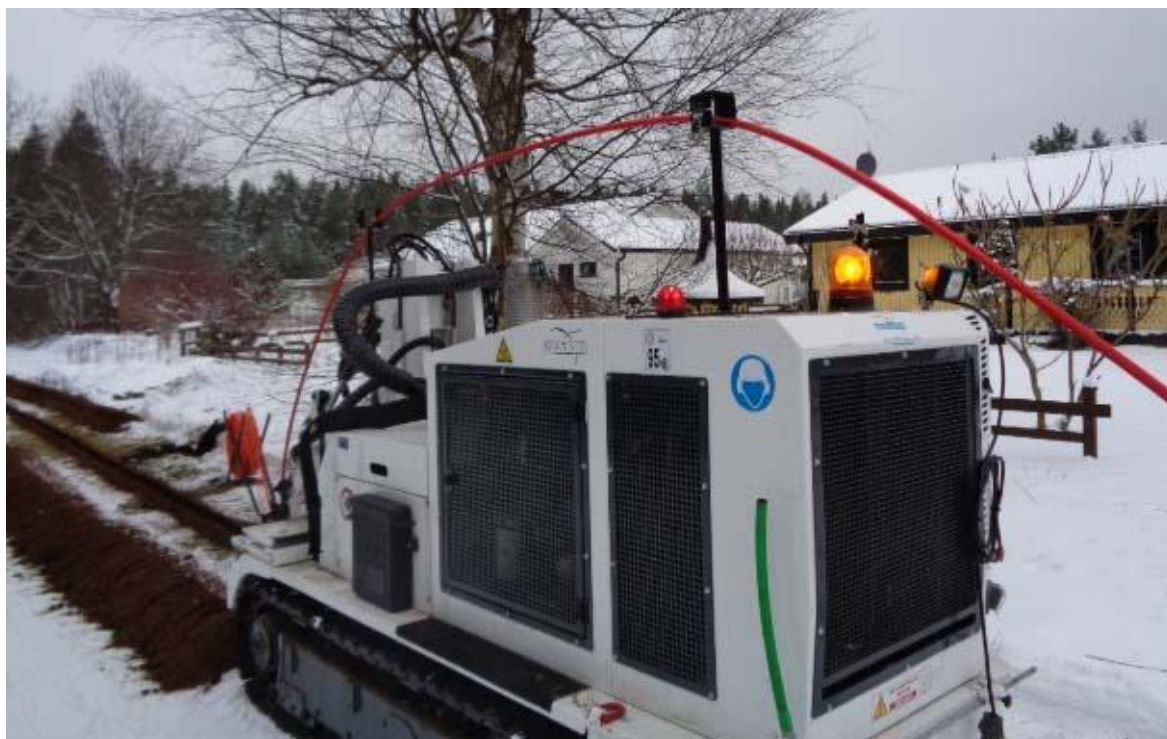
Figura 2 – Inserção imediata dos dutos na terra com mole poughing.
